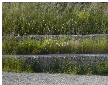
Soutènement réalisé avec des gabions successifs
