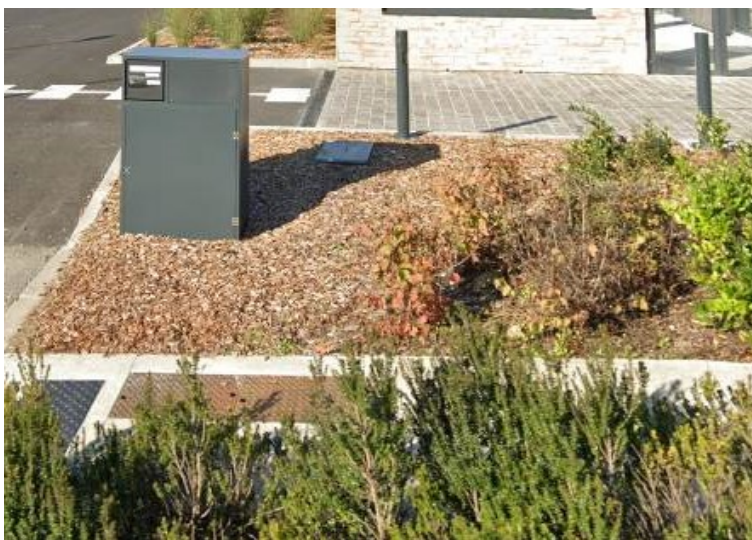
Muret d'entrée intégrant les coffrets et boîtes aux lettres et permettant de marquer l'entrée de la parcelle
