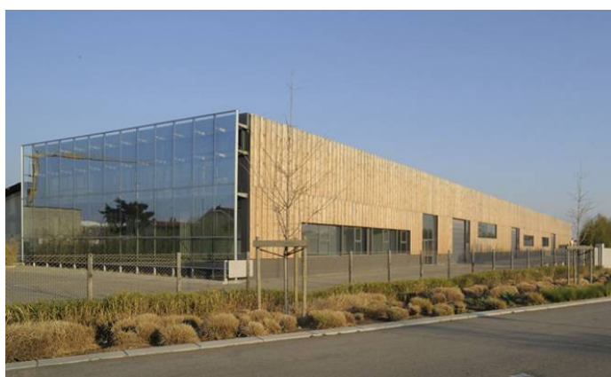
Bardage bois teinte naturelle – unité de matériau sur la façade
