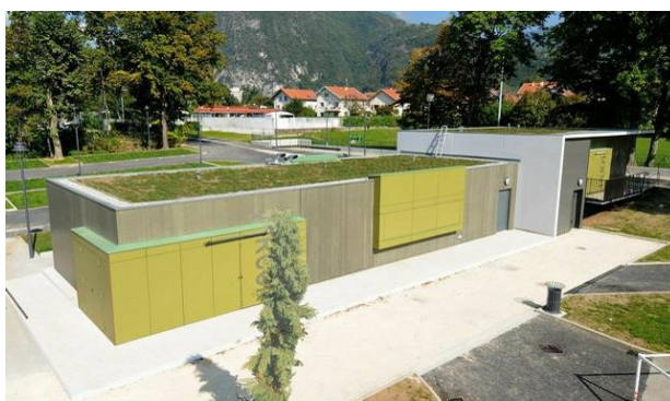
Toitures végétalisées sur volumes en rez-de-chaussée
