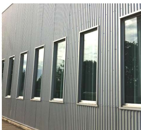
Bardage acier Fréquence 13.18 (petites ondes)
